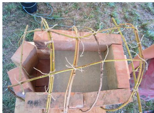
Wenn die 4 Bögen fertig sind, werden von den hinteren beiden Löchern 2 zusätzliche Weidenäste bis nach vorne gebogen und mit den Bögen verknotet.
