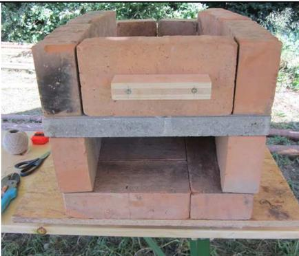
Dann werden 4 Ziegel hochkant aufgestellt. Sie bilden die Seitenwände der Brennkammer. Dann folgt eine Betonplatte (40 x 40 cm) und wieder 4 Ziegel für die Seitenwände der Backkammer.
