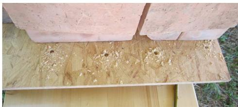
Nun werden an jeder Seitenwand außen 4 Löcher gebohrt. In diese Löcher werden später die Weidenäste gesteckt.
