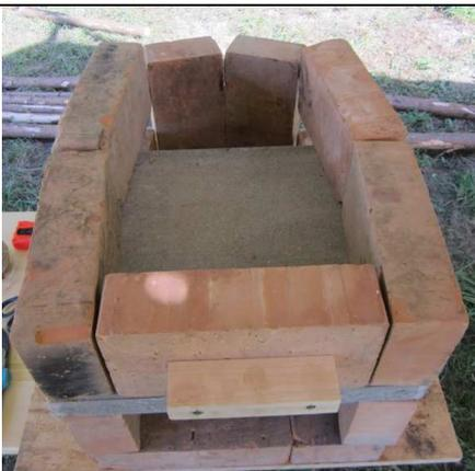
An der Rückseite werden die letzten beiden Ziegel im Hochformat aufgestellt. Diese Ziegel dürfen nicht zu nahe an die Betonplatte gestellt werden, da über diesen Weg die Abluft der Brennkammer nach oben ziehen muss.
