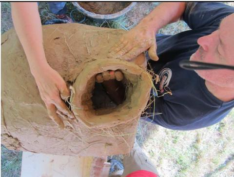
Zuletzt wird der Rauchfang an der Vorderseite aufgesetzt.
