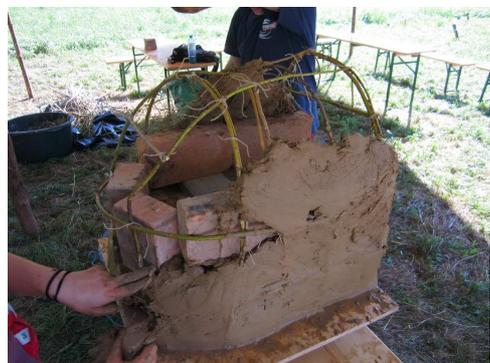
Nun wird das Gerüst mit Lehm umbaut. Beginne zuerst unten und arbeitest Dich dann nach oben.
